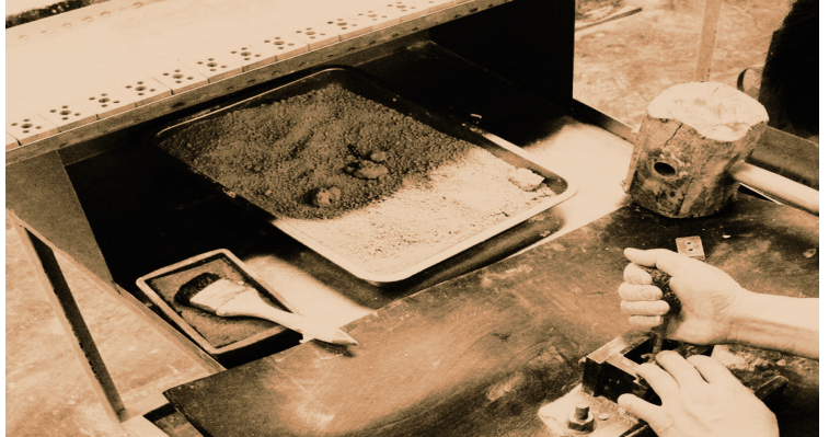
Borniers en porcelaine fabriqués manuellement par pressage au marteau : remplissage manuel du granulat humecté (Collection privée)
