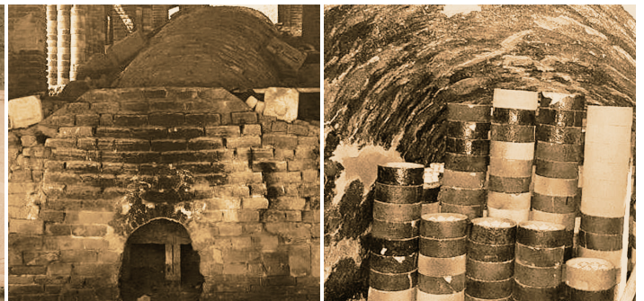
Four Dragon traditionnel chinois (龙窑 Long Yao), vue de la bouche d'alimentation et méthode de remplissage avec des porcelaines électriques (collection privée).
